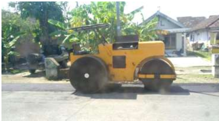
Gambar 2. Proses Mengaspal Jalan
