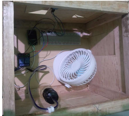
Gambar 6. Pemasangan Alat Kontrol Lampu Dan Kipas Angin Tampak Dalam
